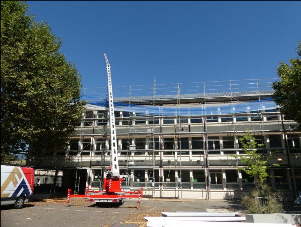
Rénovation de l'école élémentaire René-Cassin
